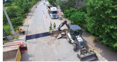
"15 Bin Ton Sıcak Asfalt Çalışması"
