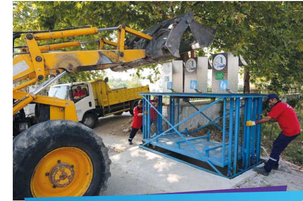
Karadenizliler Mahallesi Yer Altı Çöp Konteyner Montajı
